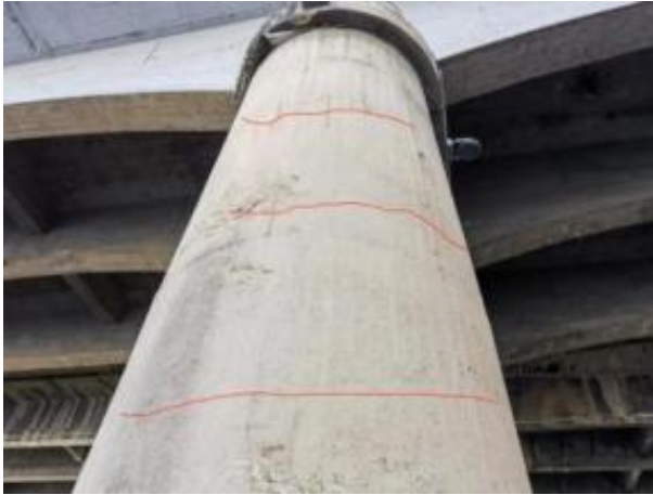
3#墩环向裂缝
