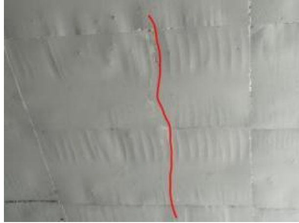
主梁纵向裂缝
