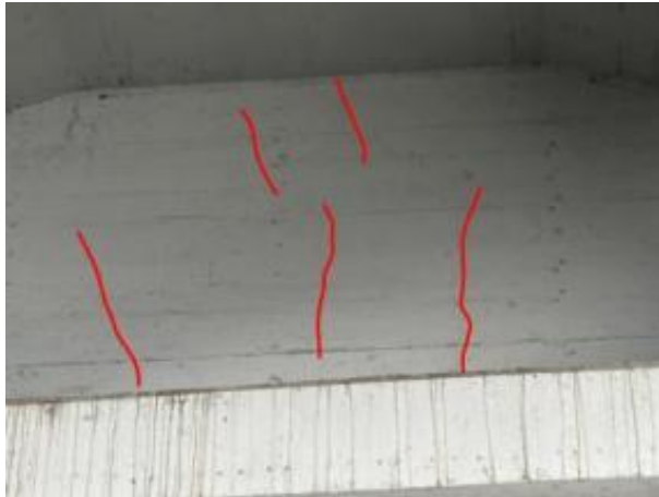
横隔板竖向裂缝
