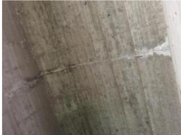
横隔板横向通长裂缝
