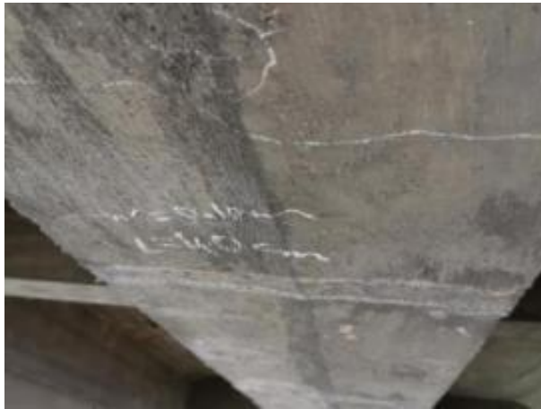
主梁横向贯通裂缝
