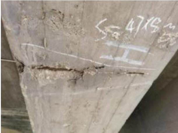
主梁底部锈胀露筋
